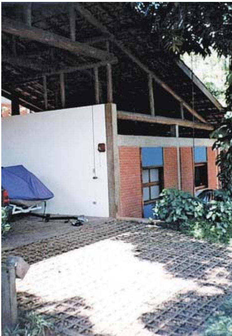
FORA DA CASA - Bloco de concreto intertravado vazado com grama
